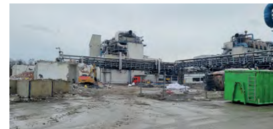
Abrissarbeiten an der Breslauer Straße im März 2022
